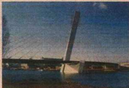
Tra passato e futuro Il Ponte Strallato, completato nel 2006, sorge sul canale industriale ovest di Porto Marghera: l'avveniristico pilone centrale è inclinato di 19 gradi
